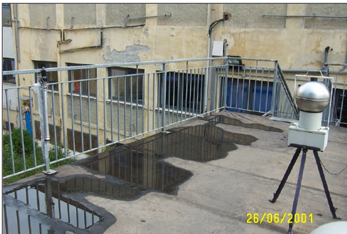
Fig. 2 - Stazione di monitoraggio in continuo del rateo di dose gamma in aria
