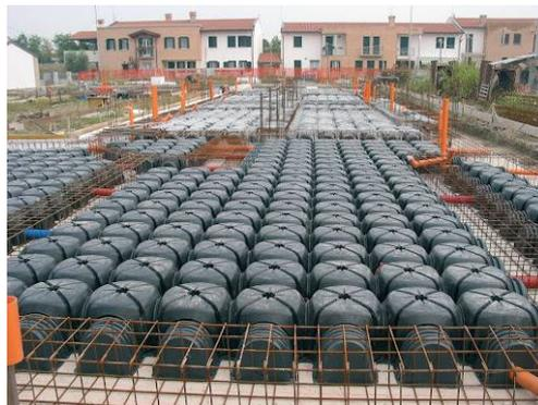
In conclusione in fase di progettazione di nuove abitazioni una fondamentale misura di protezione dal radon è l'isolamento dei locali a contatto col suolo tramite vespaio aerato e tramite scannafosso aerato nel caso di presenza di pareti contro terra.
