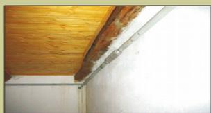
Inserimento di “**catene**” metalliche a livello dei solai e della copertura per contrastare il ribaltamento delle pareti.
