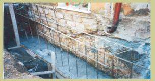
L'aumento della **resistenza** delle murature avviene per es. consolidando la muratura con intonaco armato o con un cordolo armato sulle fondazioni.
