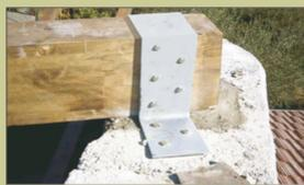
I **collegamenti** efficaci tra i solai o le coperture e le murature verticali avvengono con **staffe terminali** e **ancoraggi** che ne impediscano lo sfilamento.
