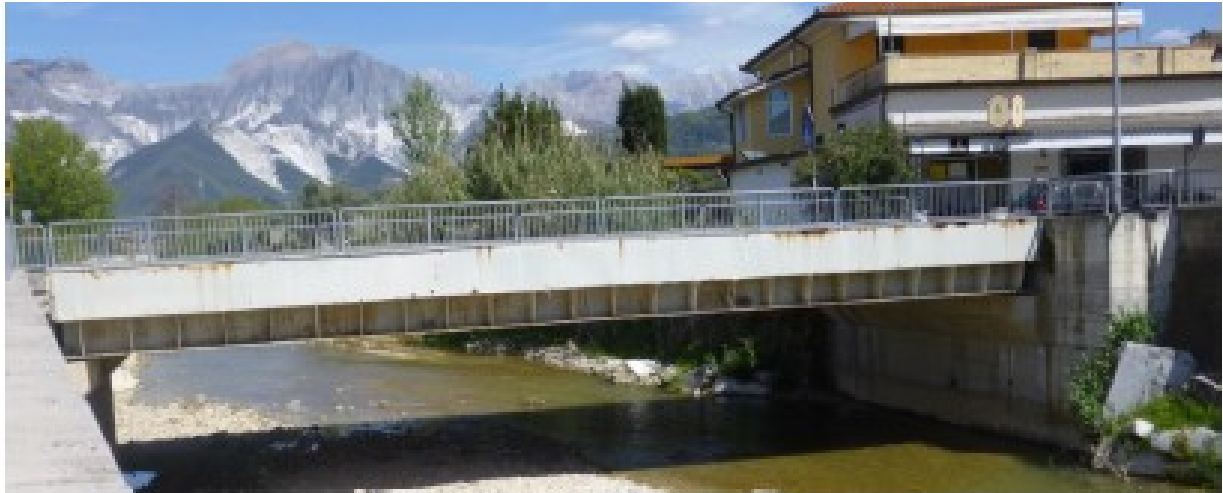
Figura 1 – Ponte di Via Menconi-Giovan Pietro visto da valle (Fonte: studio “Analisi strutturale dei manufatti di contenimento laterali e trasversali del T. Carrione. Valutazione dello stato attuale e proposte di intervento”)
