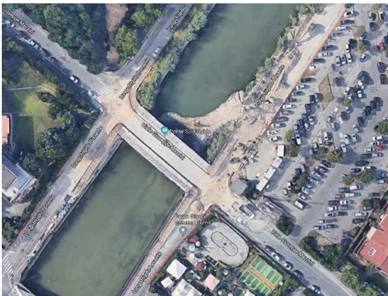
Vista aerea del cantiere per il rifacimento del ponte di via Mascagni – via Mazzini
