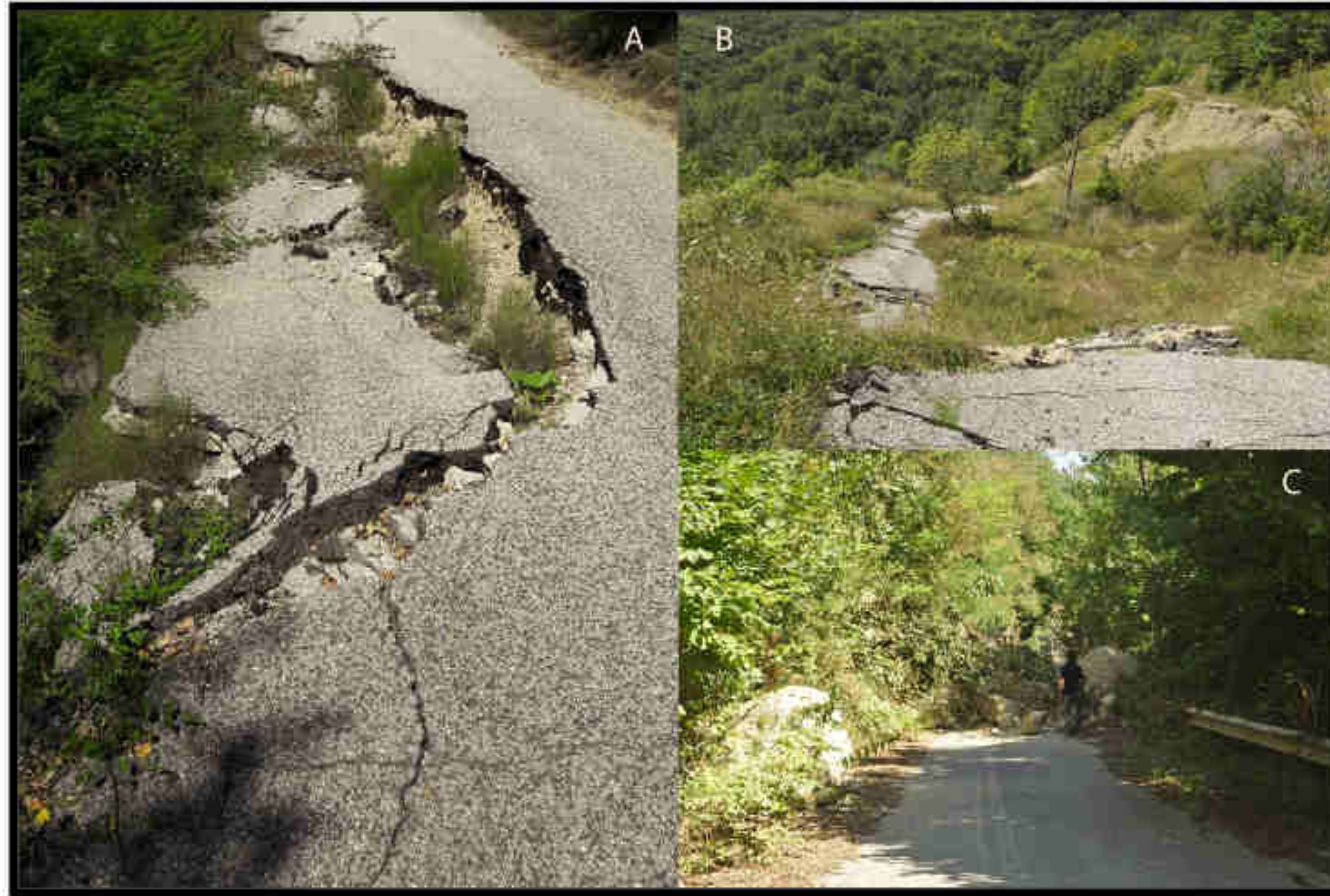
Foto 2. A) e B) Frana creatasi nel 2009 in località Ortolano, probabilmente riattivata durante la sequenza sismica attuale; C) frana di neoformazione che interrompe una piccola strada asfaltata.
