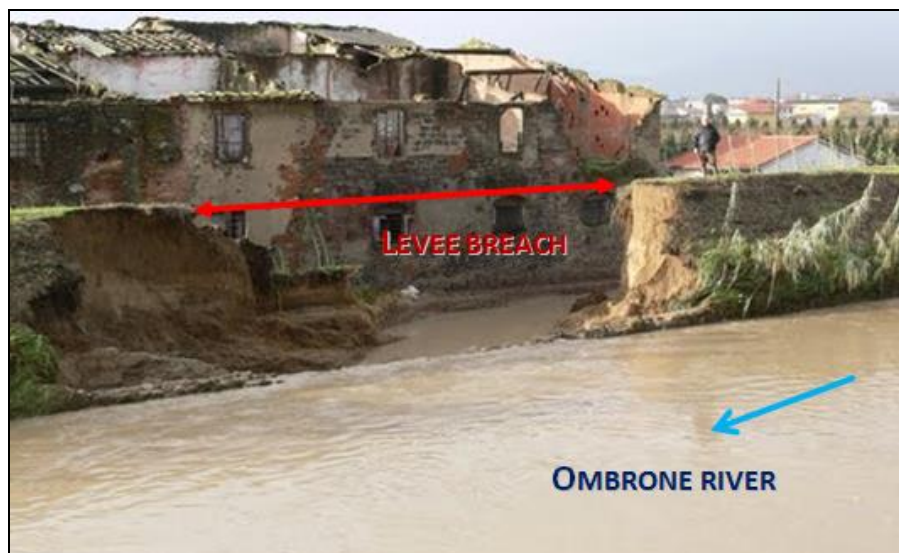
Figura 25. Foto della rotta del torrente Ombrone nel Dicembre 2009.
